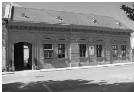
Slika 9. Ružičkina kuća poslije obnove (snimio I. Hubalek, 2007.09.13.)
